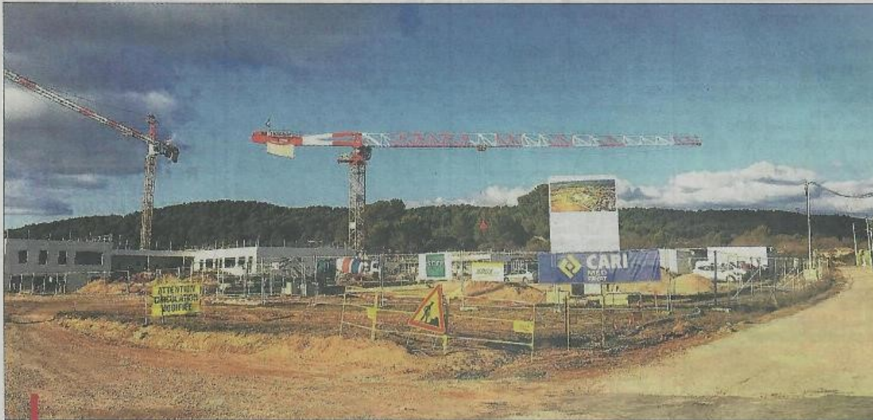
Plusieurs aménagements sont en cours de construction ou à venir, comme le collège Notre Dame au quartier des moulières.
